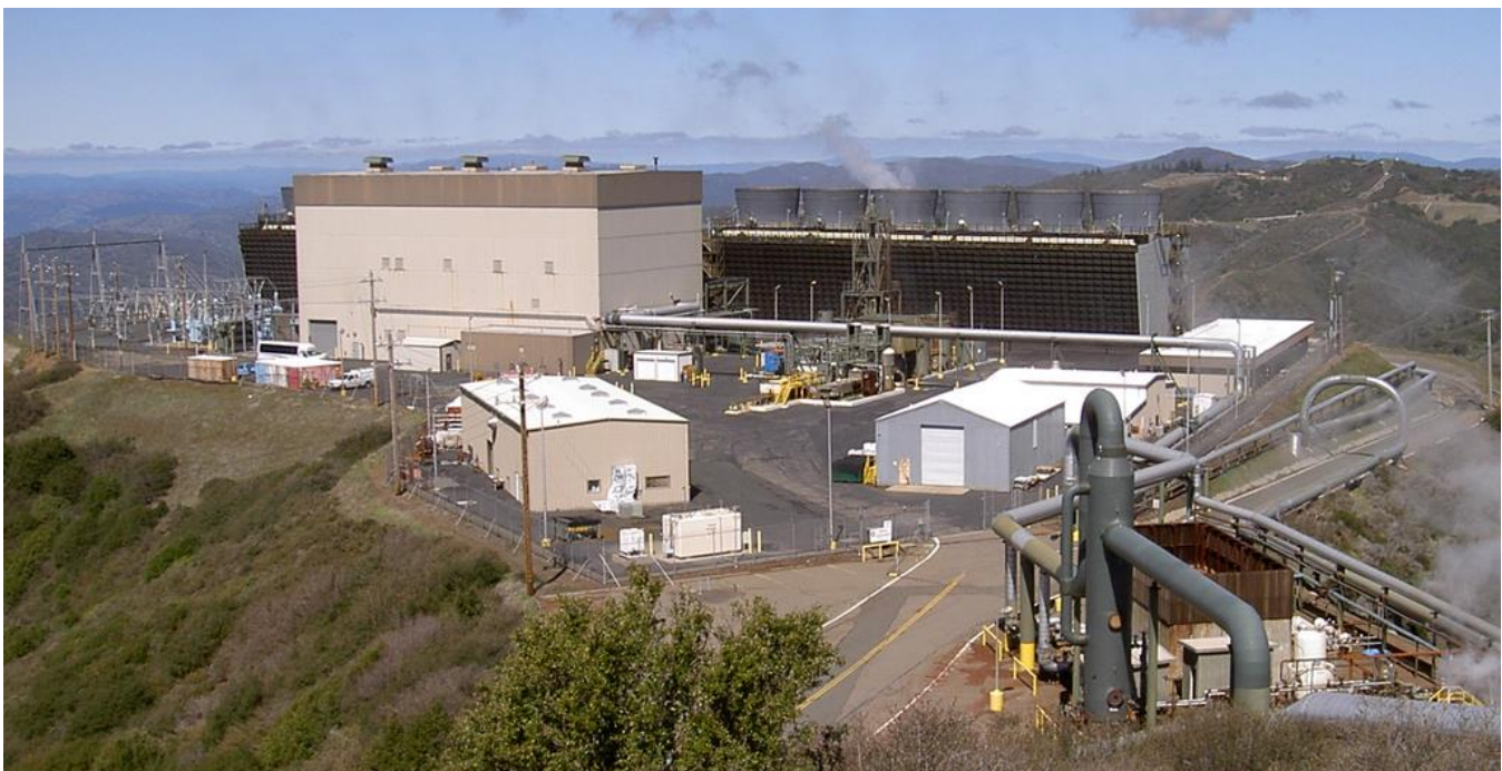
شکل 51 نیروگاه زمین گرمایی 3 Sonoma Calpine در میدان Geysers در کوههای Mayacamas در شهرستان Sonoma ، کالیفرنیا شمالی. عکس گرفته شده به سمت شمال غربی از هلیکوپتر مجاور.
